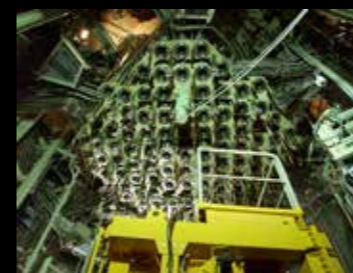
原子炉圧力容器底部のコントロールメカニズム
