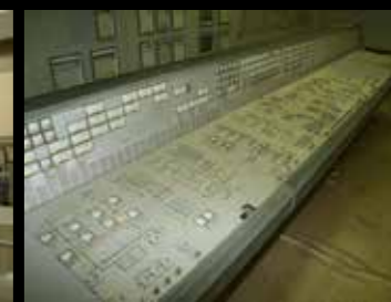
運転室の制御パネル
