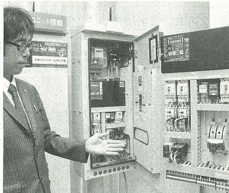
遠隔管理できる装置が取り付けられたマンホールポンプの制御盤
