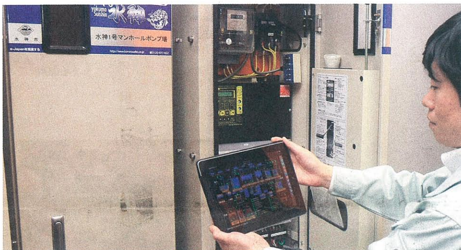
タブレット端末を通じ、制御盤操作を行う小松電機産業の遠隔水管理システム「やくも水神」＝松江市乃木福富町
