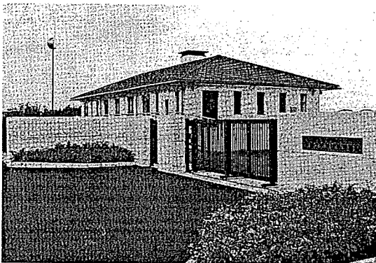
小葉大本地区処理施設外観
