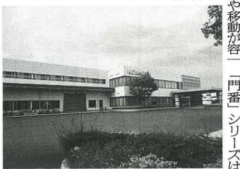
小松電機産業本社の外観
