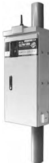
写真1 マンホールポンプ制御盤
