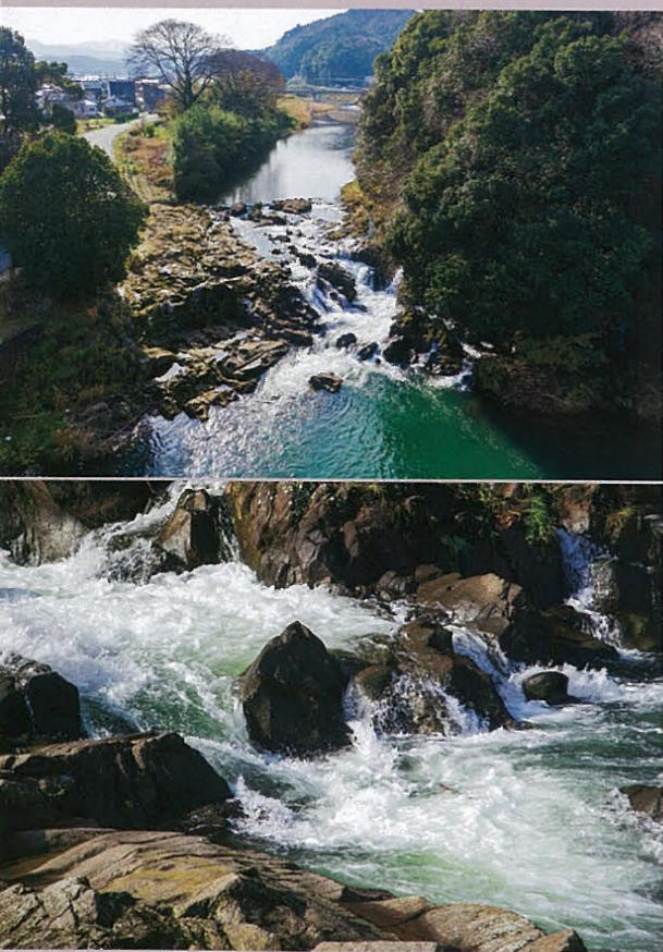
上/八雲町日吉の切り通し。開削前は、剣山から続く稜線が川をせき止めて氾濫を招いた。削られた断面は高さ20mを超えるという。下/今も鑿の痕が残る手掘りの川床。
