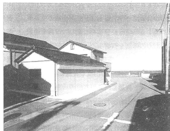
開発した、鋸に強い軽量シャッター「シーサイドシャッター」を新発売した(写真)。特長は次のとおり。①スラットとケース部に、防錆性能の高いガルファン鋼板に二層の高性能特殊塗膜を施したものを探用したこと、防錆力を高めるとともに開閉に伴う擦り傷の発生を抑制することができる②ガイドレールと水切は、鋸びにくいやアルミ形材を採用③シャフト、ホイール、バネ等の巻き取り部を熱収縮チューブで覆っているため、海浜地域に浮遊している海塩粒子がケース内に浸入してもバネが鋸びにくくなることから、機能性が長時間維持できる④耐風圧強度は600Pa(61kgf/m<sup>2</sup>)と、JIS基準=500Pa(51kgf/m<sup>2</sup>)を上回る設計とした⑤施工に関しては、鋸びが発生しやすい溶接施工を止め、防錆性能の高いボルト、ビス、リベットによる取付を行う、シーサイドシャッターの施工は、シーサイドシャッター施工講習の修了者に限定している。
