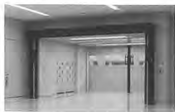
ナブコシステム…世界最速 毎秒5.0メートル、両引分 開閉方式「ノボスプリント」
