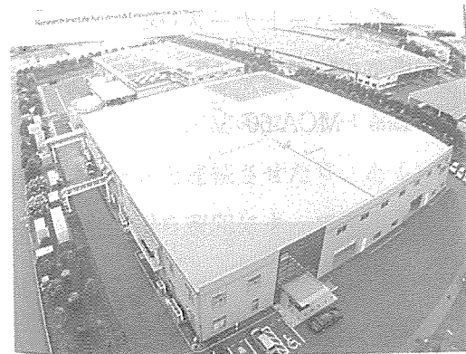
ライフイン環境防災研究所 既存のEAST棟(手前)と増築したWEST棟(奥)
