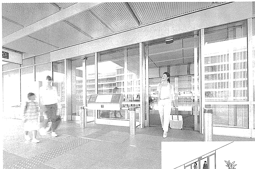
ナブコ自動ドア「インテリジェント eco ドアシステム」 人の動きを読み取り、横切るだけの人には開かない
