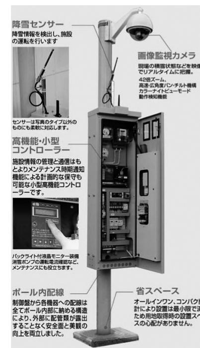
写真5 消融雪設備管理制御システム
