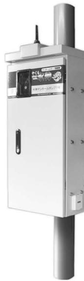
写真7 マンホールポンプ制御盤
