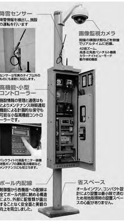
写真5 消融雪設備管理制御システム
