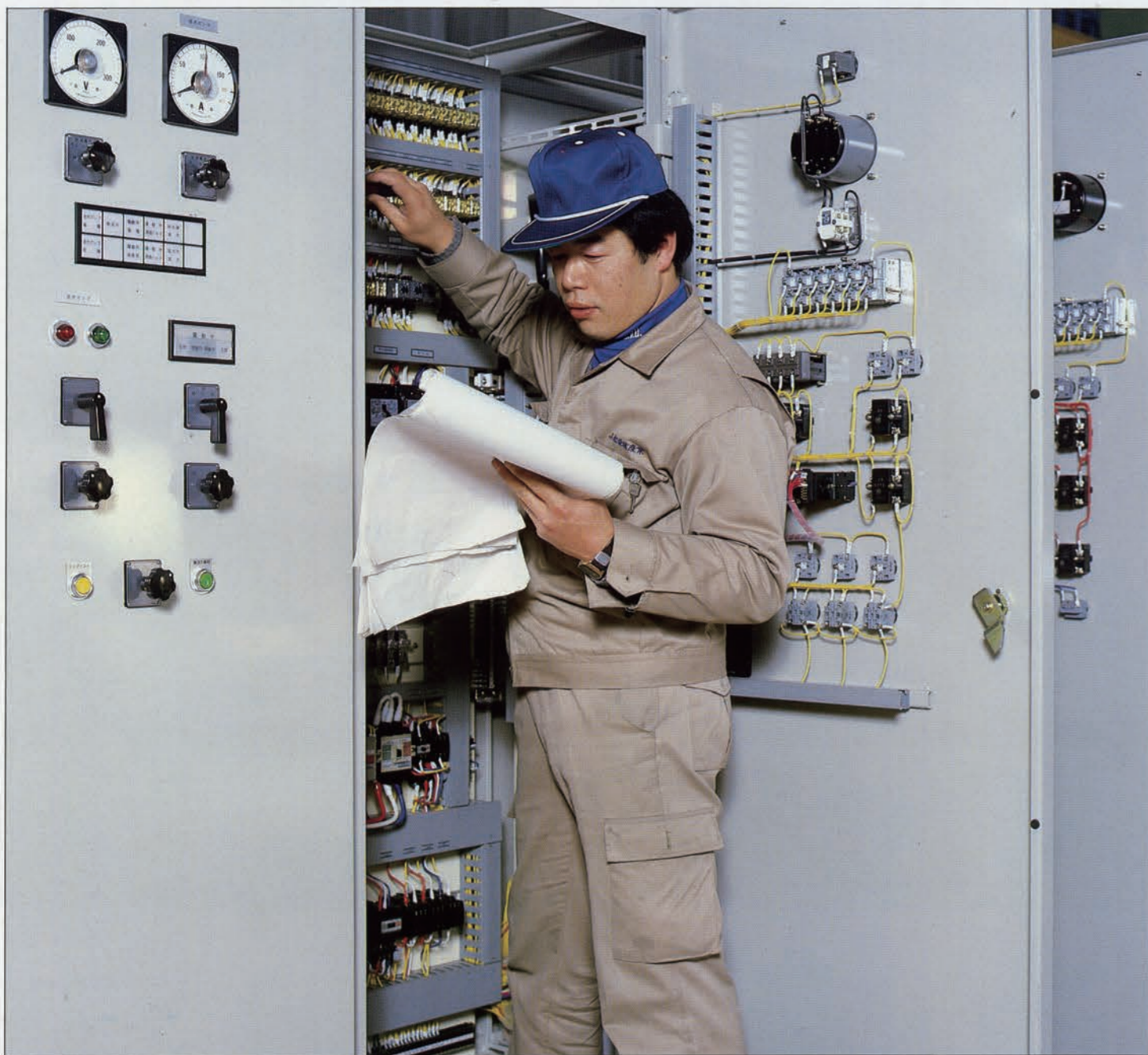
電気配線検査
