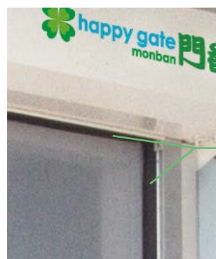
巻き取りボックス部 サイドフレーム部 エアタイトシール (注文仕様)
