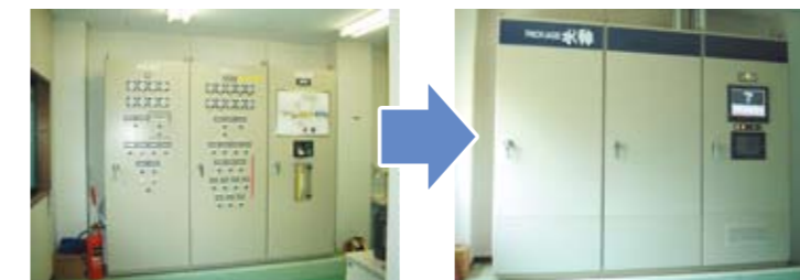
パネルコンピュータ+タッチパネル拡張ユニットを設置
