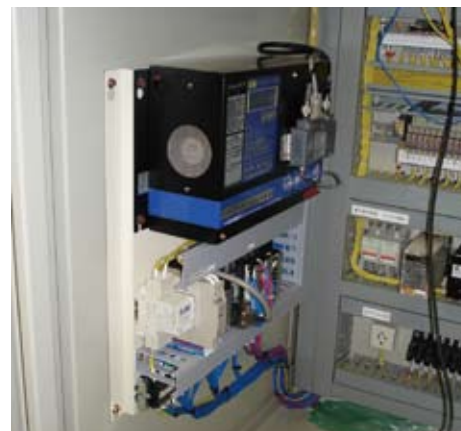
バイオマス施設制御盤にPLC拡張ユニット設置
