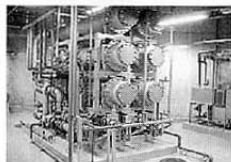
予備エンジン(地階設置)
