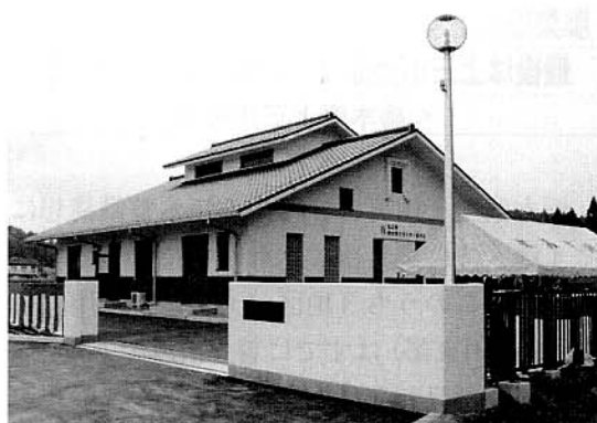
松之郷地区農業集落排水処理施設外観
