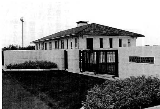
小葉大本地区処理施設外観
