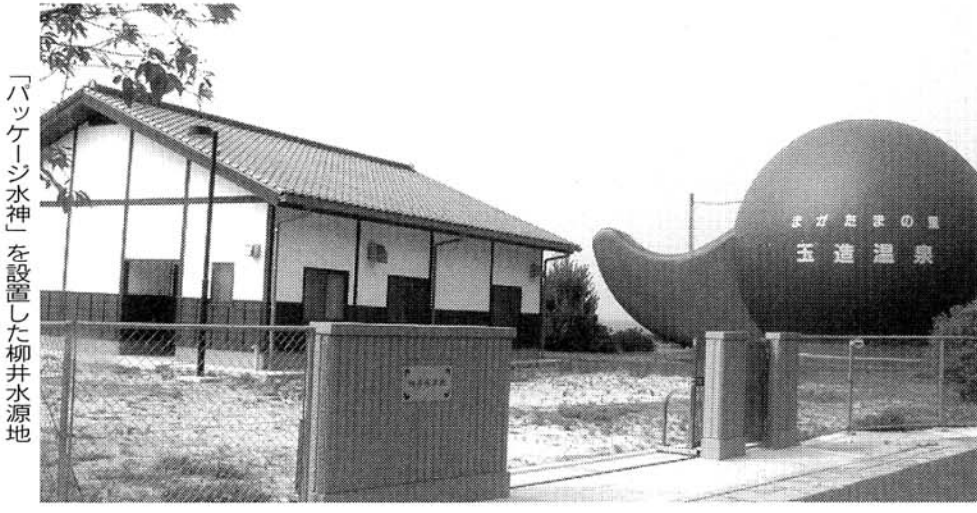
「パッケージ水神」を設置した柳井水源地
