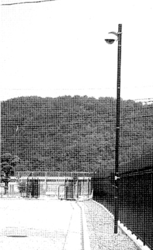
「画像監視ユニット」としてカメラ設置(浜田市)
