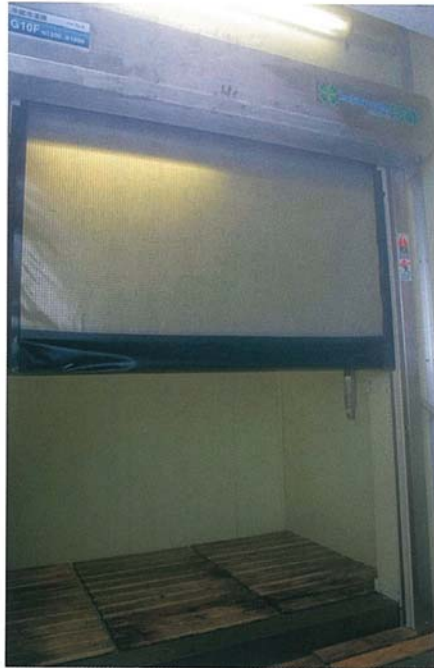
冷蔵冷凍庫仕様のシートシャッター。 マイナス25度でも作動する
