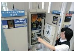
自治体の上下水道施設などに設置されている「やくも水神」。情報はデータセンターに集約され、どこからでも監視できる(松江市で)
