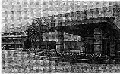
このほど竣工した小松電機 新社屋
