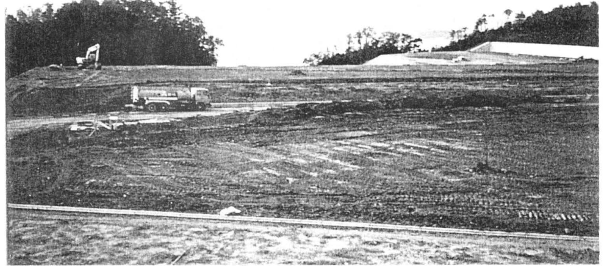
宍道湖をのぞむ新工場建設予定地
