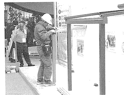
テラス施工実現
