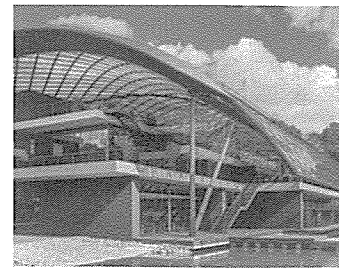
特殊技研金属・高難度設計の 変形3次元トップライト施工 例。部材の設計から製作・施 工まで抜群の物件対応力
