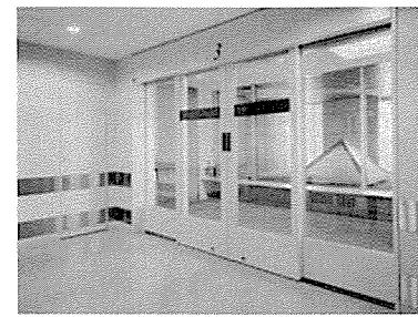
寺岡オートドア…業界随一の品揃えと施工実績を誇る「耐熱ガラス入りテラオカ特定防火設備」施工例
