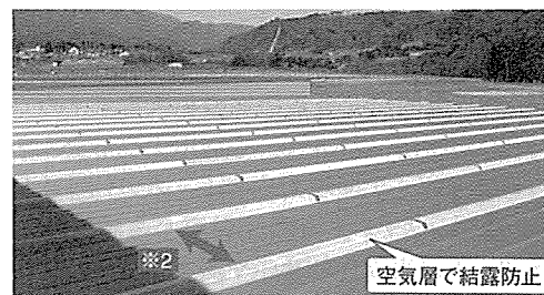
元旦…防水性と意匠性に優れた屋根一体型のトップライト
